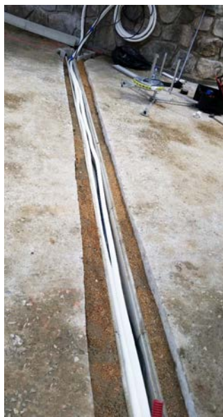
1. Un caniveau technique (visitable) d'une longueur de 6 m a été réalisé entre le local chaufferie et les unités extérieures pour le passage des liaisons frigorifiques et des câbles électriques. Il se poursuit le long du mur pour desservir les appareils en partie arrière.
