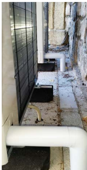
1. Un caniveau technique (visitable) d'une longueur de 6 m a été réalisé entre le local chaufferie et les unités extérieures pour le passage des liaisons frigorifiques et des câbles électriques. Il se poursuit le long du mur pour desservir les appareils en partie arrière.
