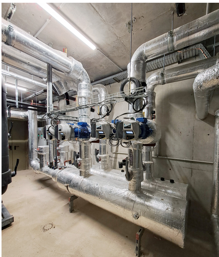
Sous-stations de chauffage et eau glacée. Crédit : Equans France.
