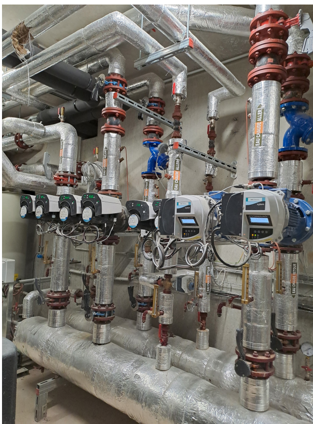
Sous-stations de chauffage et eau glacée. Crédit : Equans France.
